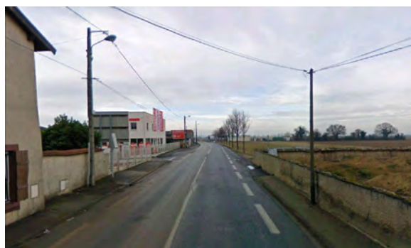
La zone d'activité, une façade à la route Nationale
