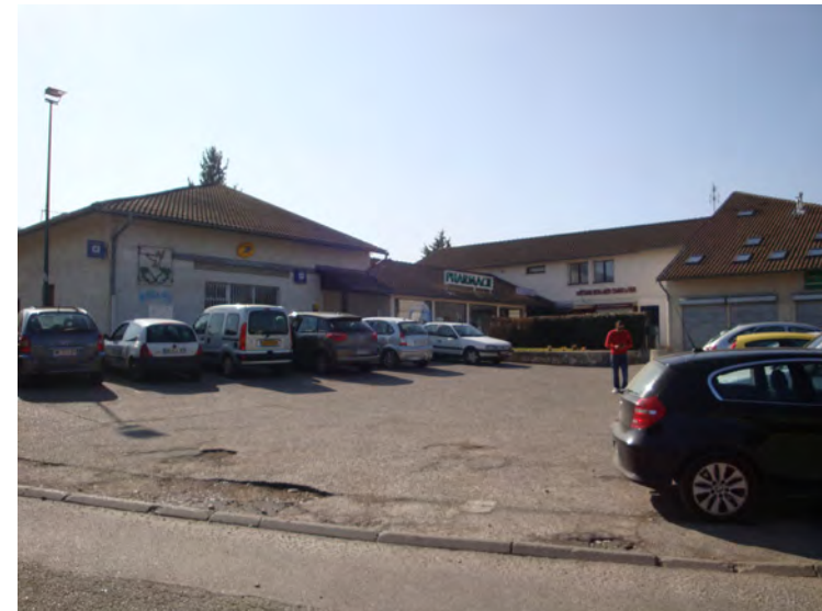
La place du Vallon, un lieu dédié à la voiture
