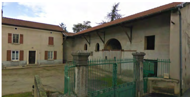
Ferme rue de l'Égalité, implantée autour d'une cour
