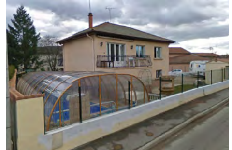
Clôture mur + grillage (treillis soudé) à nu à éviter
